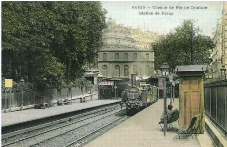
Chemin de Fer de Petite Ceinture, ehem. Station de Passy, Paris
